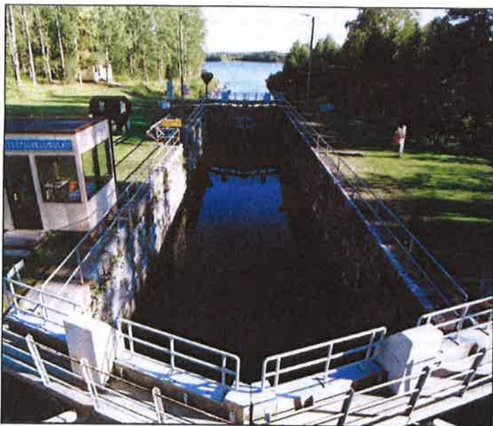
Lastukoskelle jo valmistunut auto-maattisulku on mitoiltaan 30 x 7 metriä ja kulkusyvyys on 1,8 metriä.
