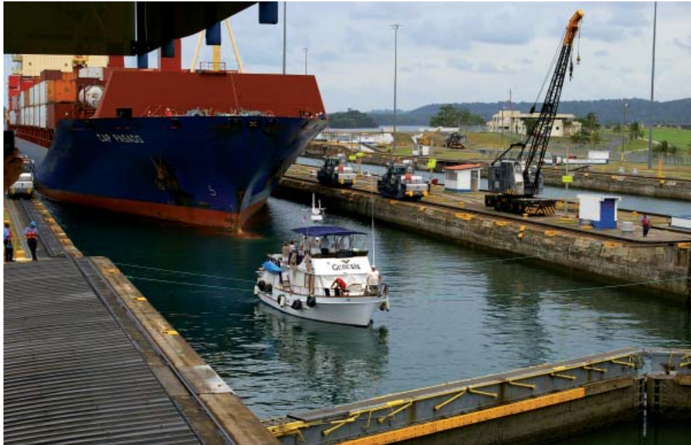
Veden vähyden vuoksi pienetkin alukset sulutetaan isompien kanssa, Gatun-sulut
